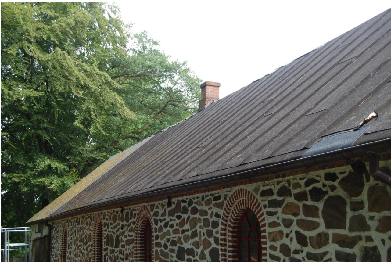
Forsamlingshusets nordside inden udskiftning
