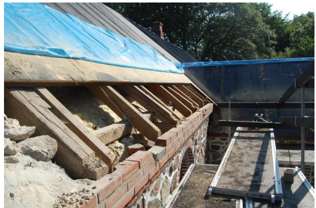
Tømreren udskifter de nederste dele af pladerne...
