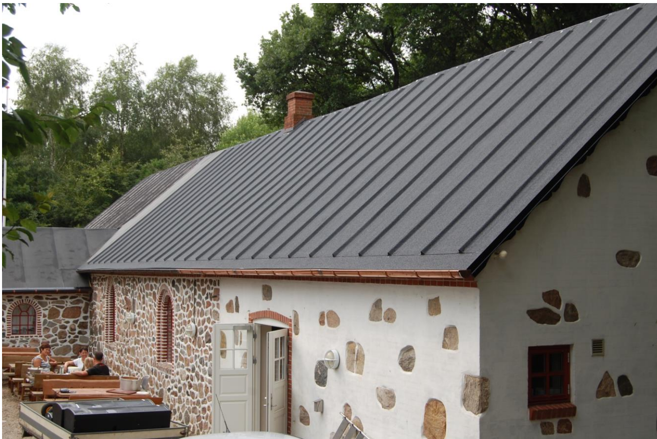
Sydøstsiden færdig. Ny tagrende monteret
